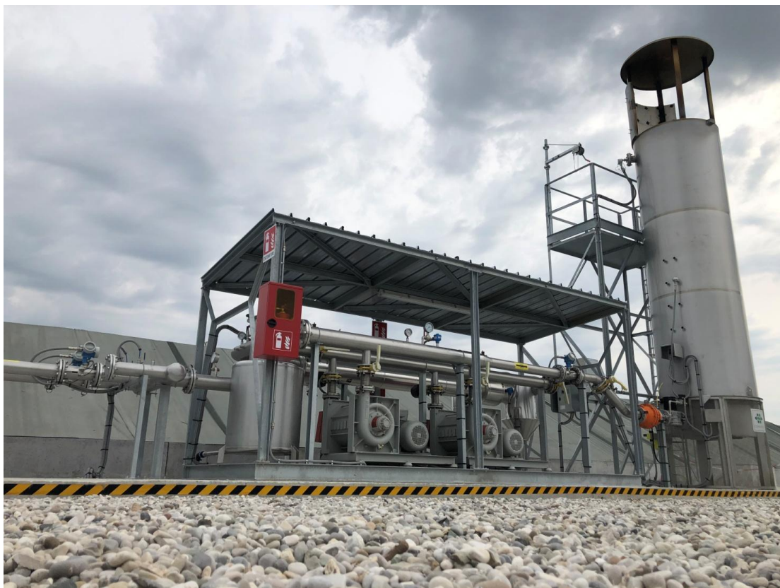
Rysunek 4.10. Palnik wysokotemperaturowy. Source: CONVECO Srl,2021. All rights reserved.
