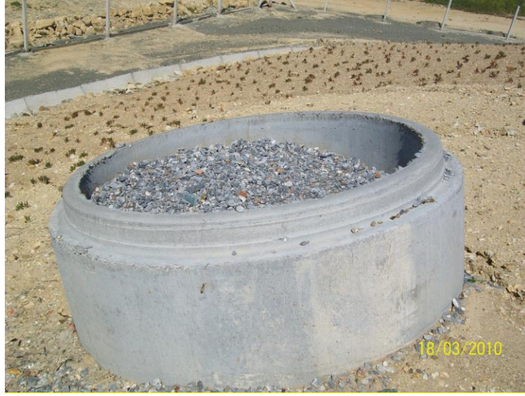
Şekil 6.2. Gaz drenaj sisteminin kurulumu
