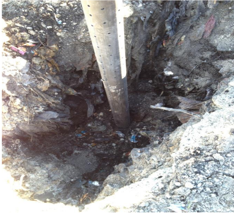
Фигура 8. Монтаж на газов комин
