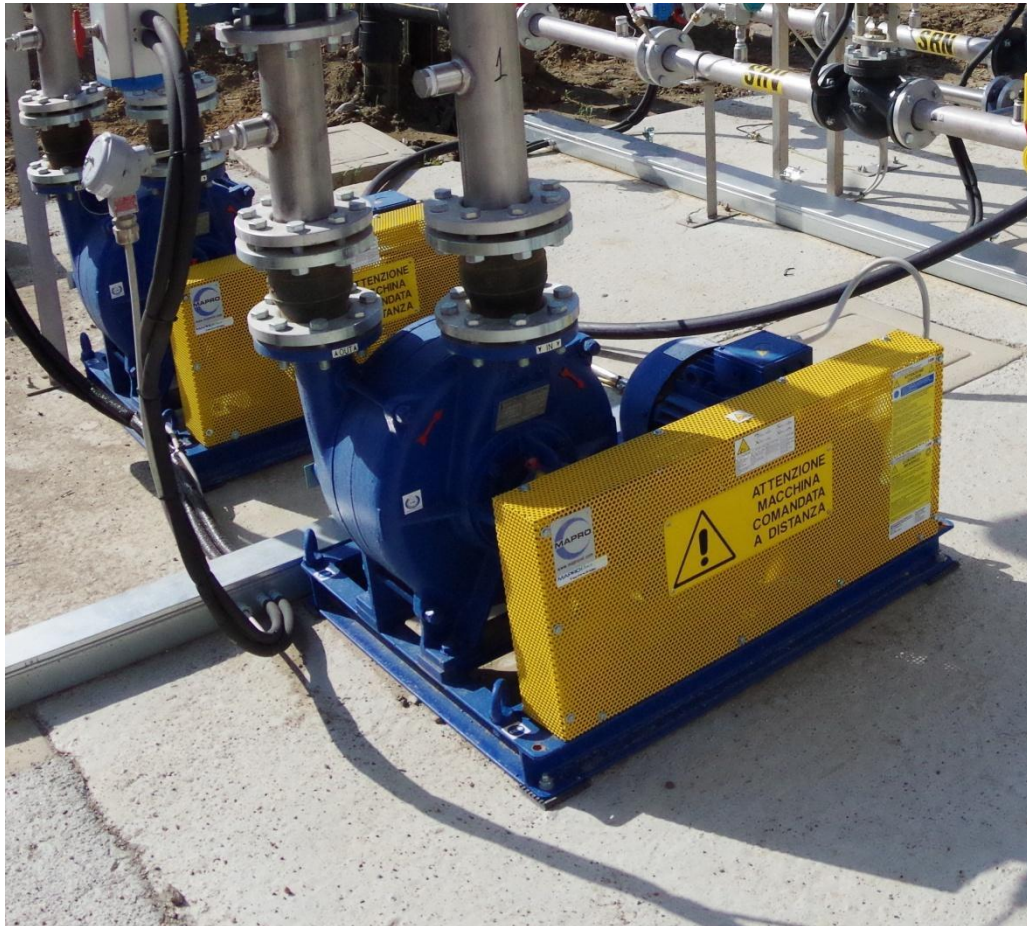
Figura 4.8. O turbo -sufletă - Ventilatoare centrifuga. Sursa: ASWM Srl, 2020. Toate drepturile rezervate.
