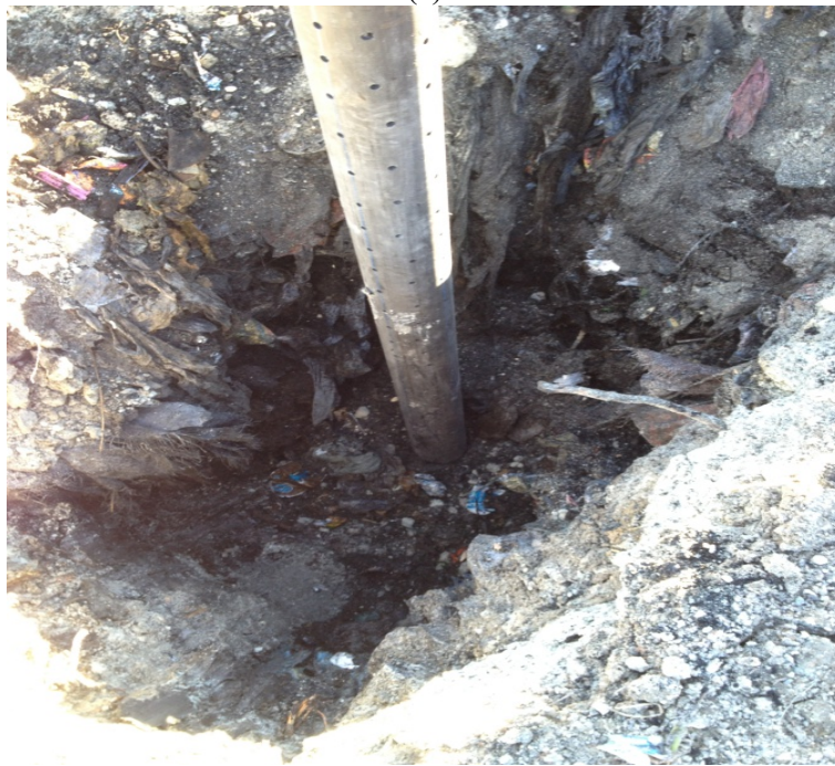
Figura 8. Instalarea coșului de gaz
