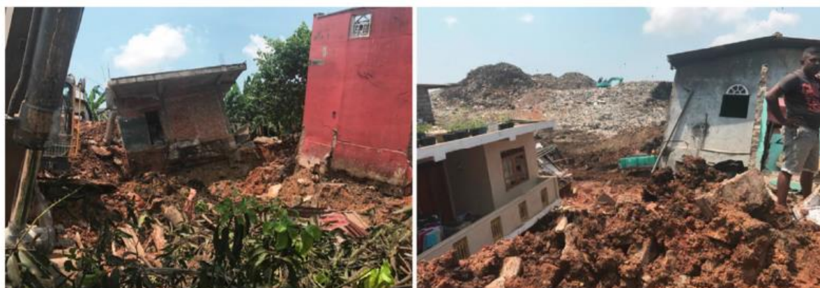
Figure 1.4. Deteriorarea locuințelor din cauza defecțiunii pantei din halda deschisă Meethotamulla (Jayaweera și colab., 2019).
