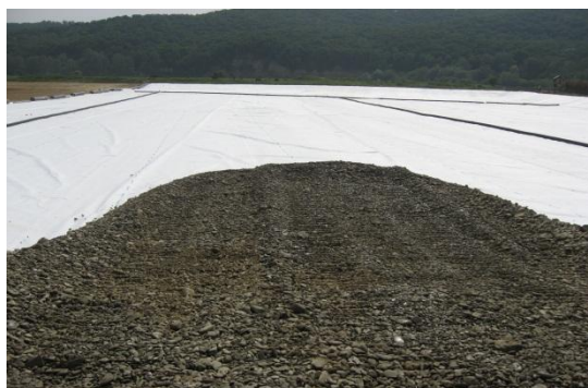
Figura 8. Instalatii de drenaj si drenaj - sectiunea B
