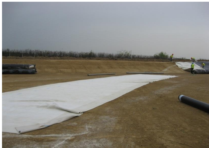
Figura 4. Construcția de geomembrane a celulelor de stocare
