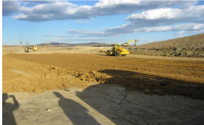
Figura 3 . Construcția terenului de celule de depozitare
