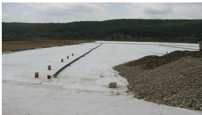
Figura 7. Instalatii de drenaj -secțiunea A
