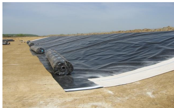
Figura 5. Construcția celulelor de stocare
