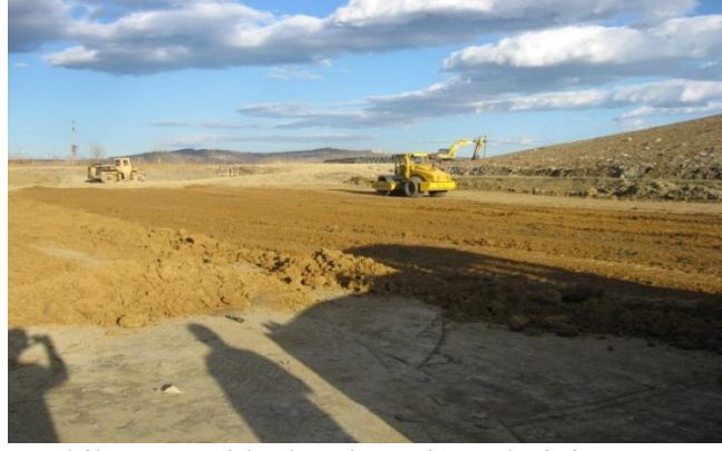
Şekil 3 . Arazide depolama hücrelerinin yapımı
