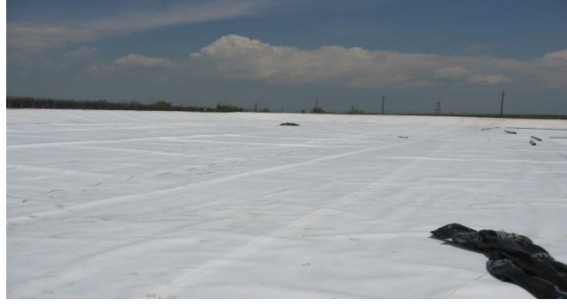
Şekil 6. Depolama hücrelerinin son örtüsü
