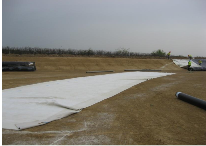
Şekil 4. Depolama hücrelerinde jeomembran yapımı
