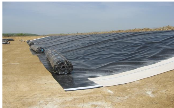
Şekil 5. Depolama hücrelerinin yapımı
