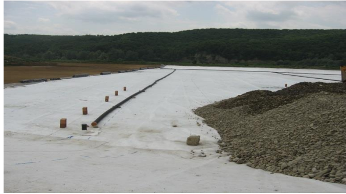
Şekil 7. Drenaj ve drenaj kurulumları-bölüm A
