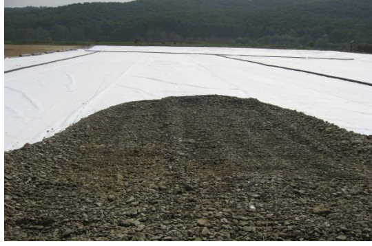
Şekil 8 Drenaj ve drenaj kurulumları- bölüm B
