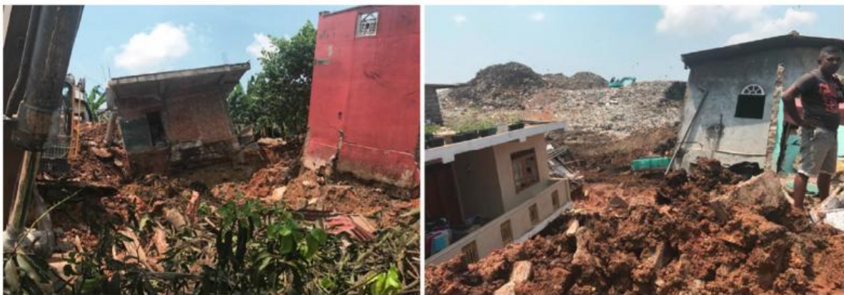
Figura 1.4. I danni alle abitazioni provocati dal cedimento dei versanti della discarica non controllata di Meethotamulla (Jayaweera et al., 2019).
