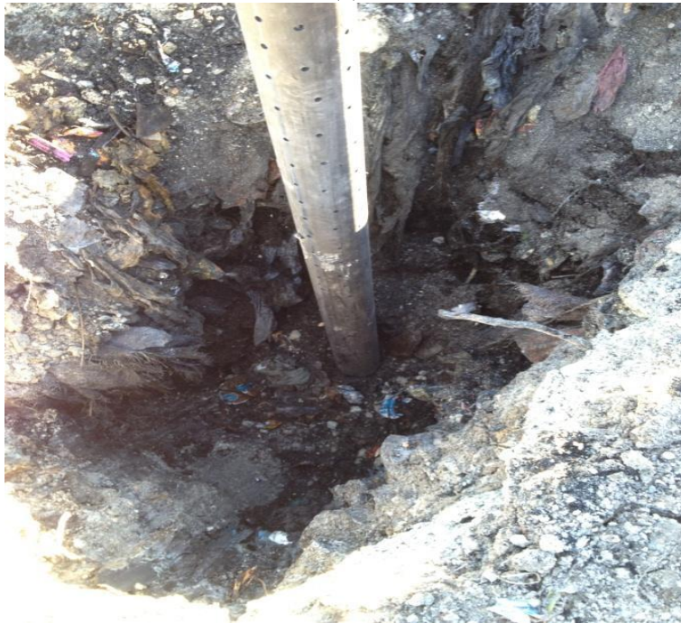
Figura 8. Installazione di un pozzo di captazione verticale del gas di discarica
