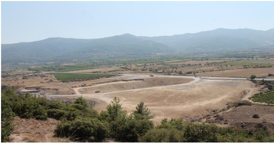
Figura 6. Immagine della visuale dalla discarica durante la creazione della copertura
