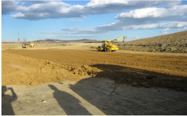
Figura 3 . Costruzione delle celle di stoccaggio del rifiuti
