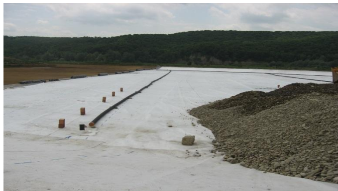
Figura 7. Installazione del sistema di drenaggio delle acque superficiali -sezione A
