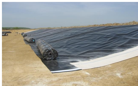
Figura 5. Posa degli strato di copertura
