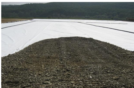
Figura 8. Stesura dello strato di ghiaia drenante- sezione B
