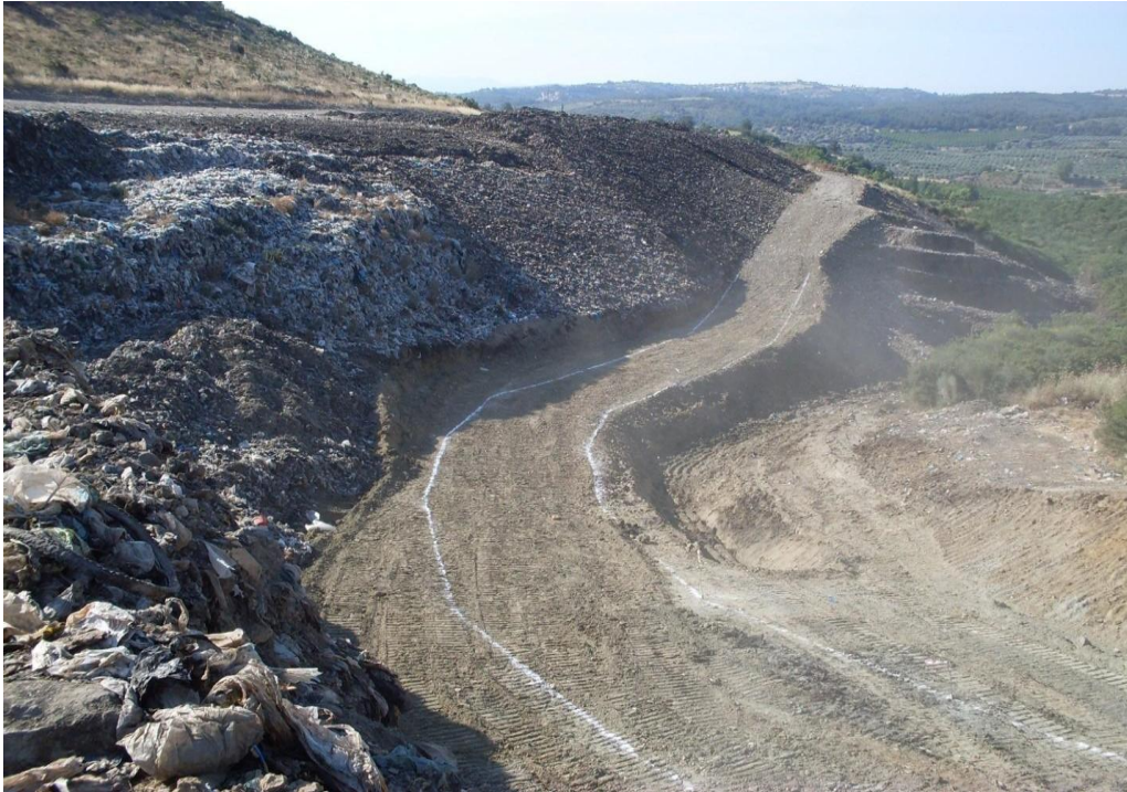
Figura 3.7. Il trasporto dei rifiuti all'interno dell'area delimitata e l'inclinazione dei versanti.
