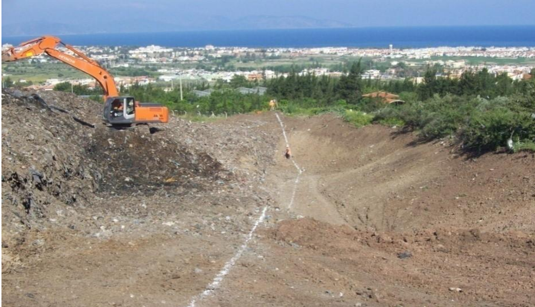
Figura 3.6. La delimitazione dei confini della discarica
