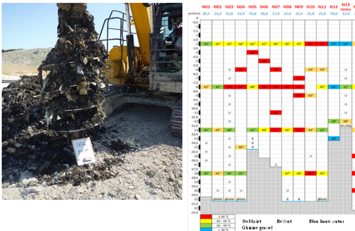
Figura 4.4. Trivellazione di un nuovo pozzo – Prospetto dei dati rilevati in una campagna di realizzazione di nuovi pozzi tramite trivellazione. Fonte: ASET Spa, July 2021.
