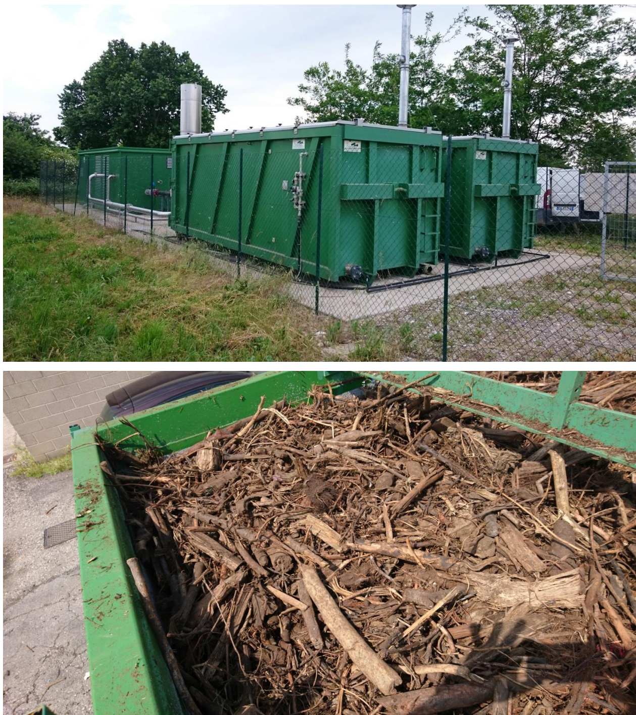
Figura 4.9. Esempi di biofiltri in vasca o in container (dettaglio). Fonte: ASWM Srl, 2021.
