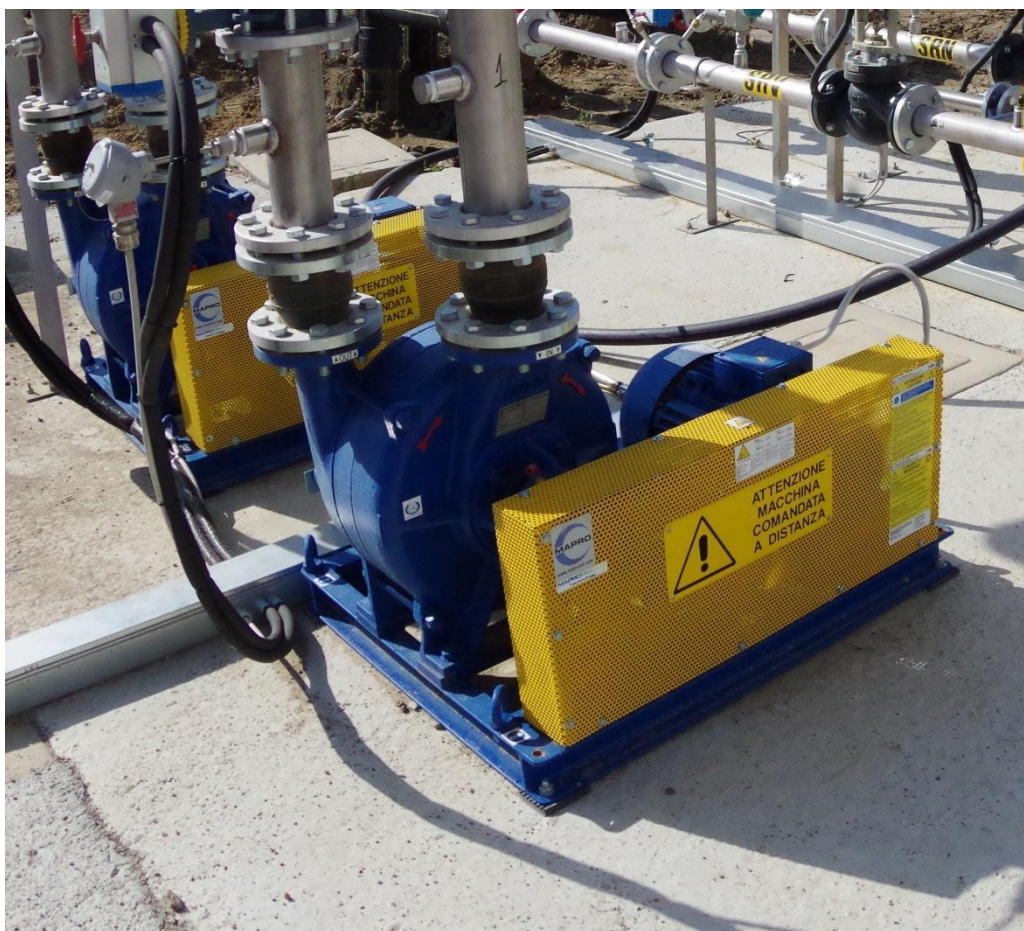
Figura 4.8. Un turboaspiratore (soffiante centrifuga). Fonte: ASWM Srl, 2020.
