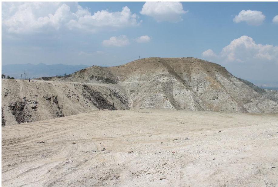
Figure 7. Discarica di Sarayköy dopo il processo di risanamento
