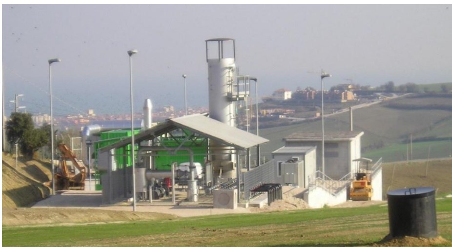
Фигура 4.7. Инсталация за добив и оползотворяване на енергия за сметищен газ.
