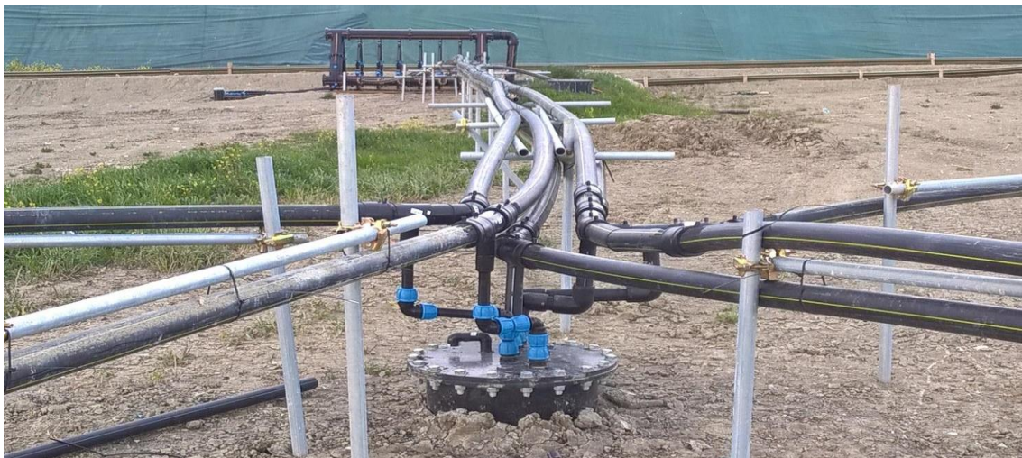
Фигура 4.6. Газопроводи за вторични сметища, положени върху опори от метални тръби - на преден план изпускател на кондензат - на заден план Регулаторна станция. Източник: ASET Spa, ноември 2020 г.
