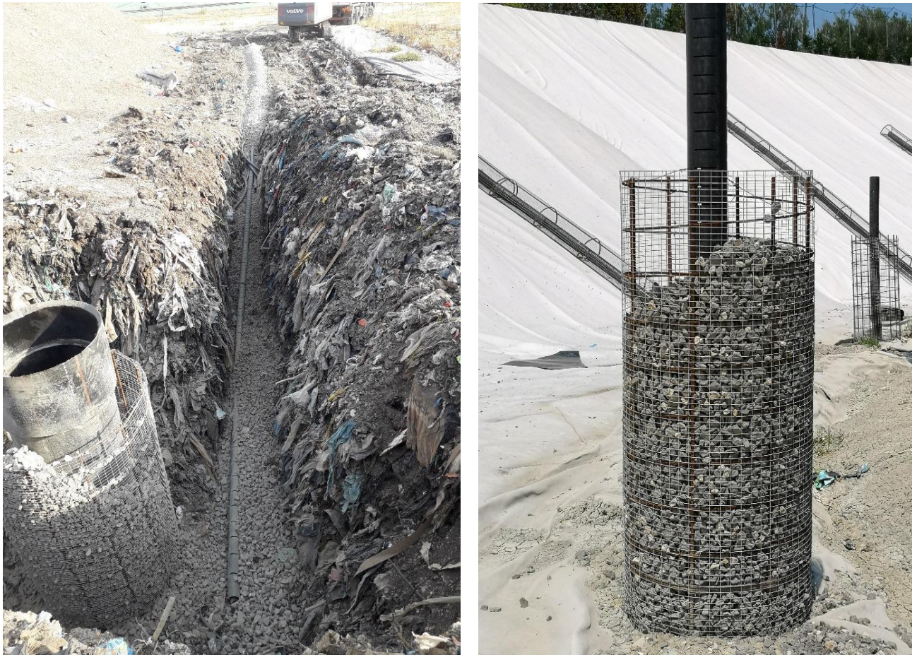
Фигура 4.3. Хоризонтален дренаж и кладенци. Източник: ASET Spa, април 2019 г.
