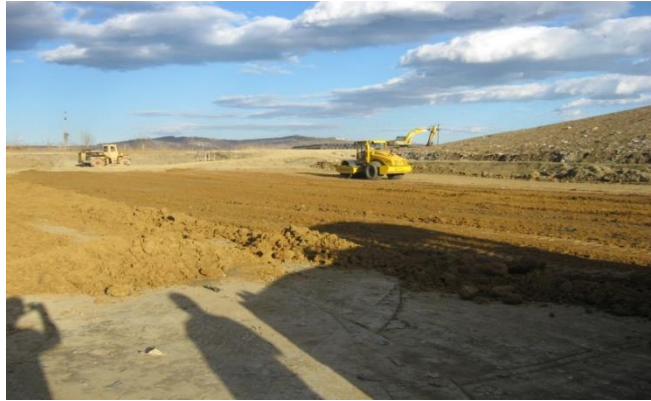
Фигура 3 . Наземно изграждане на клетките в депото
