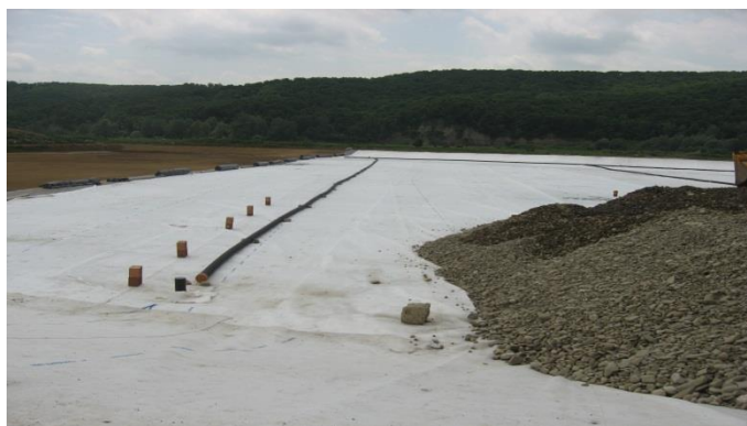
Фигура 7. Дренаж и дренажни инсталации - секция А
