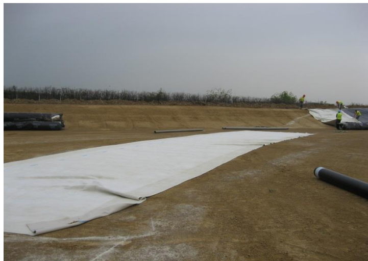
Фигура 4. Геомембранна конструкция на клетките за съхранение
