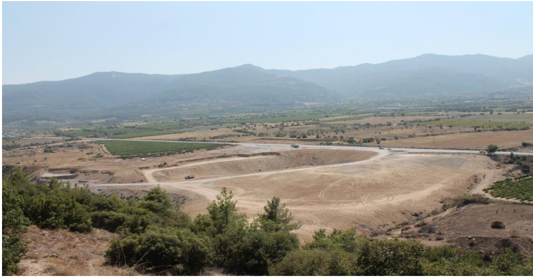
Rysunek 6. Widok nieuporządkowanego składowiska podczas formowania górnej pokrywy
