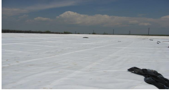
Rysunek 6. Końcowa osłona składowiska – warstwa geowłókniny
