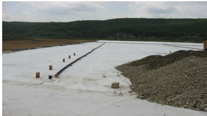
Rysunek 7. Instalacje odwadniające – odcinek A
