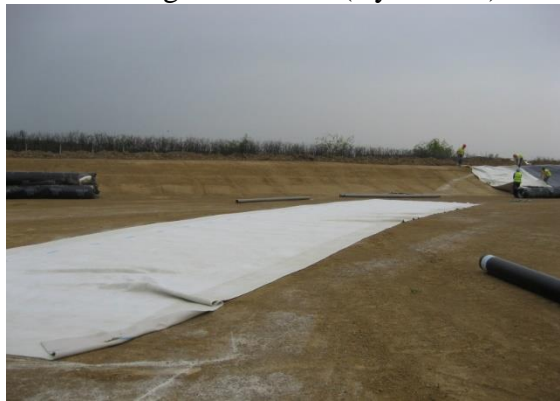
Rysunek 4. Rozłożenie geomembrany na terenie składowiska
