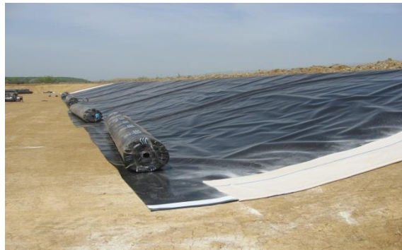
Rysunek 5. Rozłożenie drugiej warstwy geomembrany na terenie składowiska
