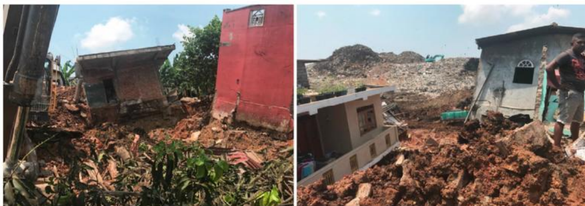
Rysunek 1.4. Uszkodzenia lokali mieszkalnych spowodowane obsuwem skarpy na nieuporządkowanym składowisku Meethotamulla (Jayaweera i in., 2019).
