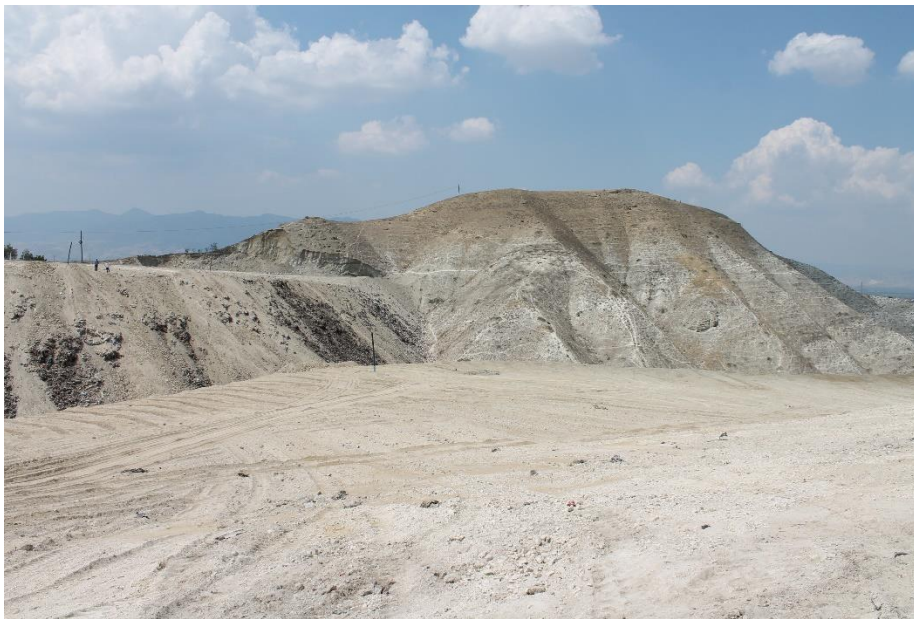
Figura 7. Groapa de deseuri cu depozitare necontrolată Sarayköy după reabilitare
