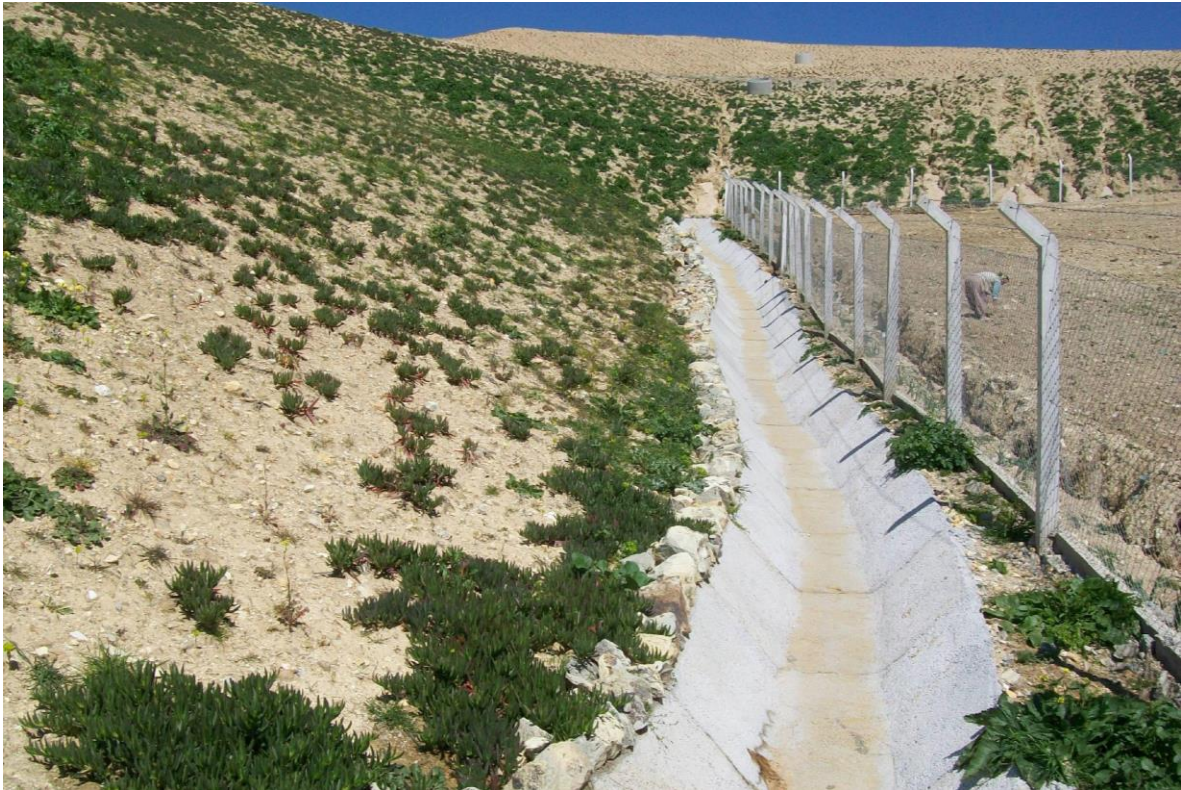
Figure 3.9. Canal de colectare a apelor de suprafață
