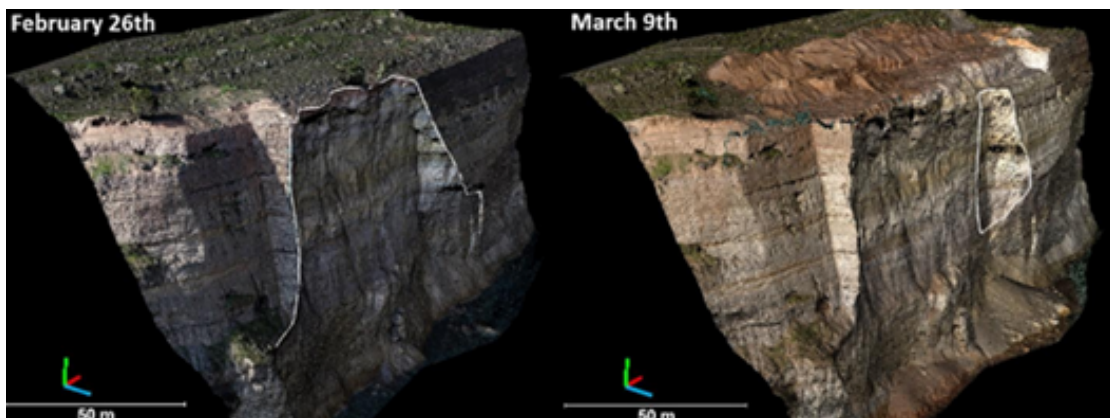
Figura 3.23. Nuvola di punti del cedimento del pendio del Canale di Corinto il 26 febbraio e il 9 marzo da Pix4d.
