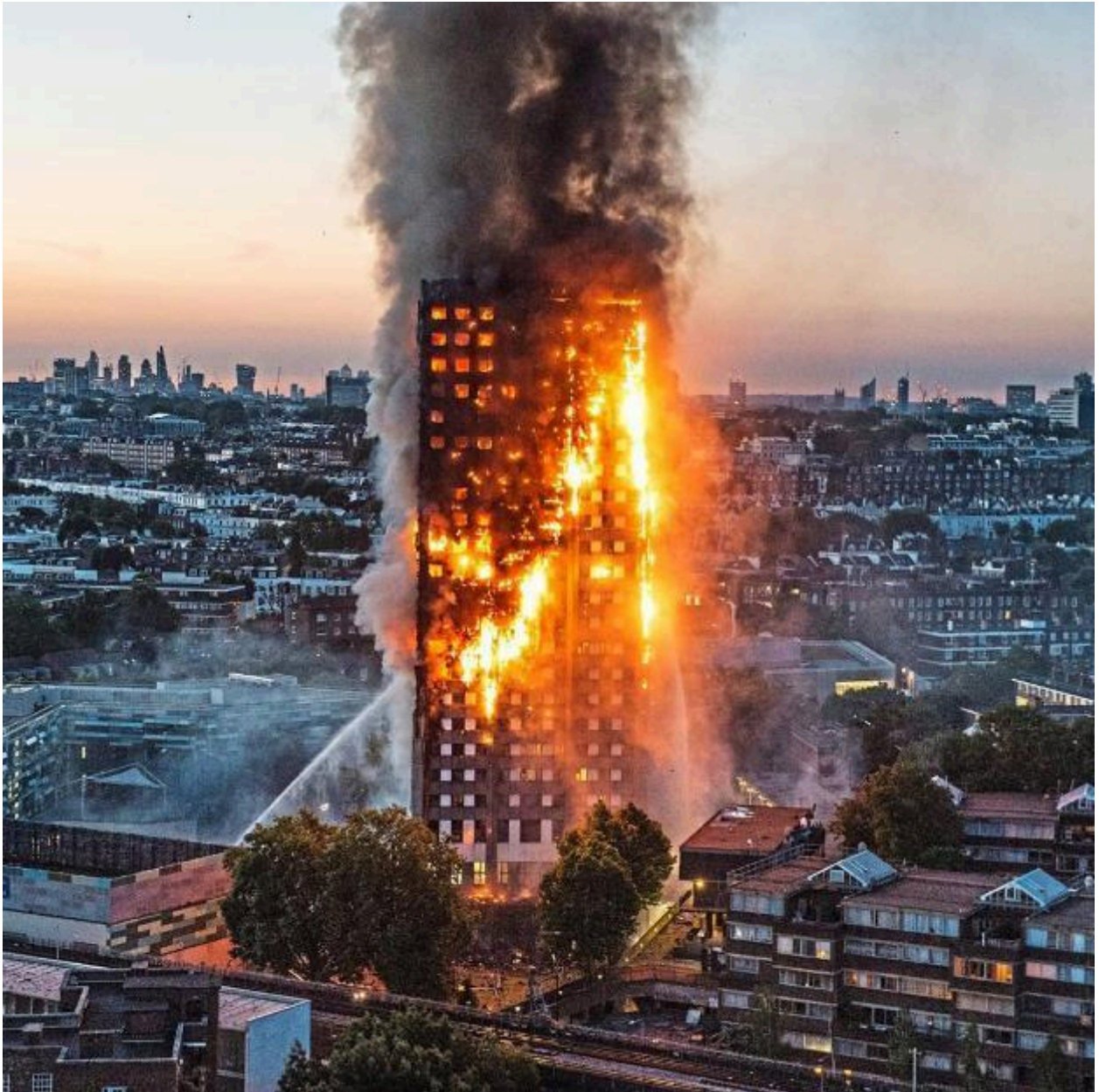
Figura 5.46. Incendio della Grenfell Tower.
