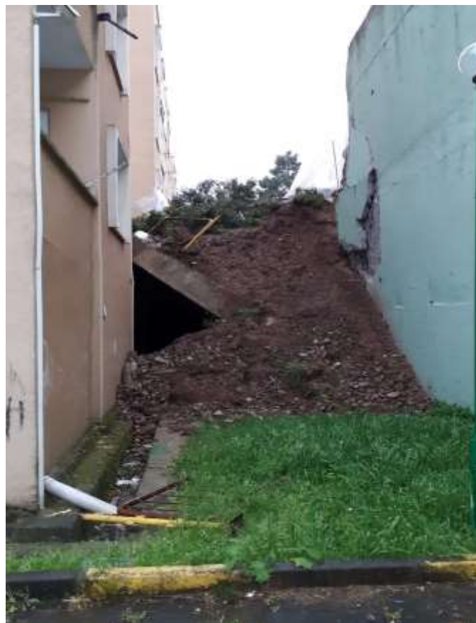
სურათი 3.18. ჩამონგრეული საყრდენი კედელი და მეწყერი
