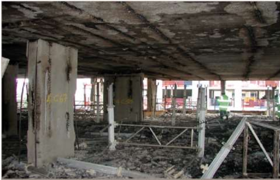
სურათი 4.10. ხანძრის ინტერიერის ხედმა დააზიანა ბეტონის კონსტრუქცია.
