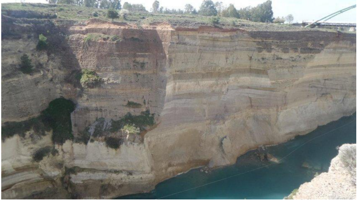
Şekil 3.22. 26 Şubat 2018 tarihinde Korinth Kanalı'nın güney şevinde meydana gelen şev kayması görüntüsü.
