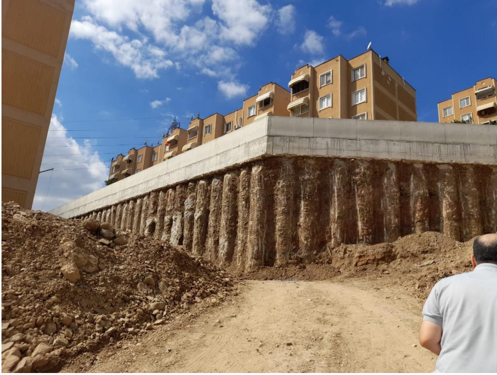
Şekil 3.20. Yeni inşa edilen istinat duvarı.
