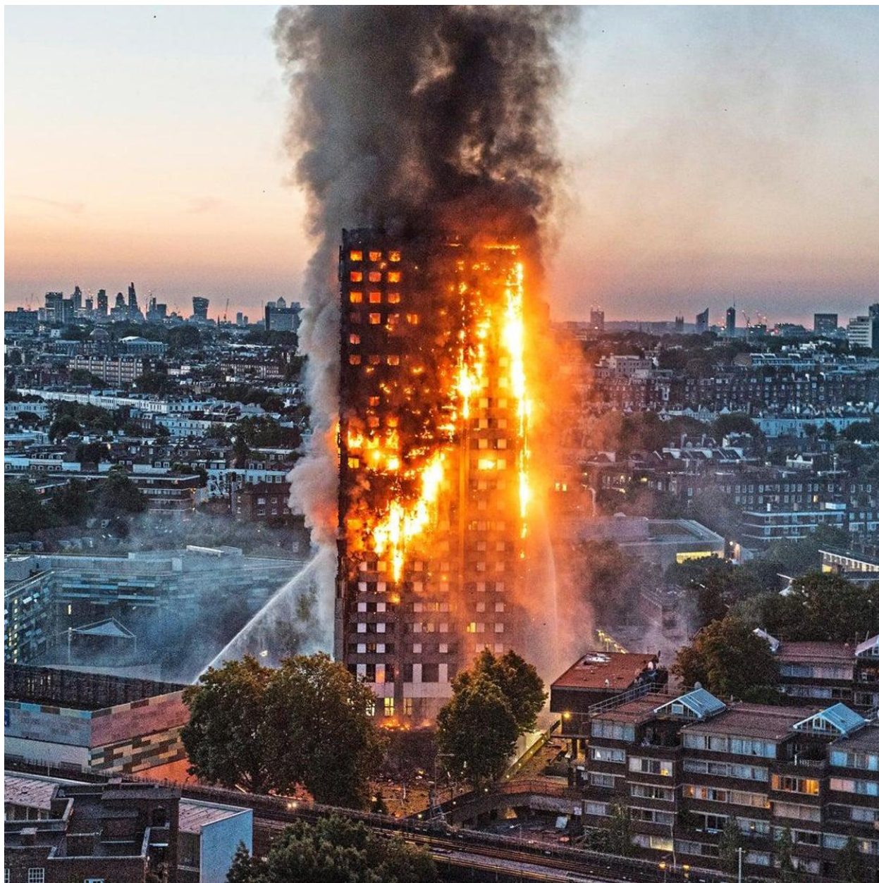
Εικόνα 5.46. Πυρκαγιά στον Πύργο Γκρένφελ.
