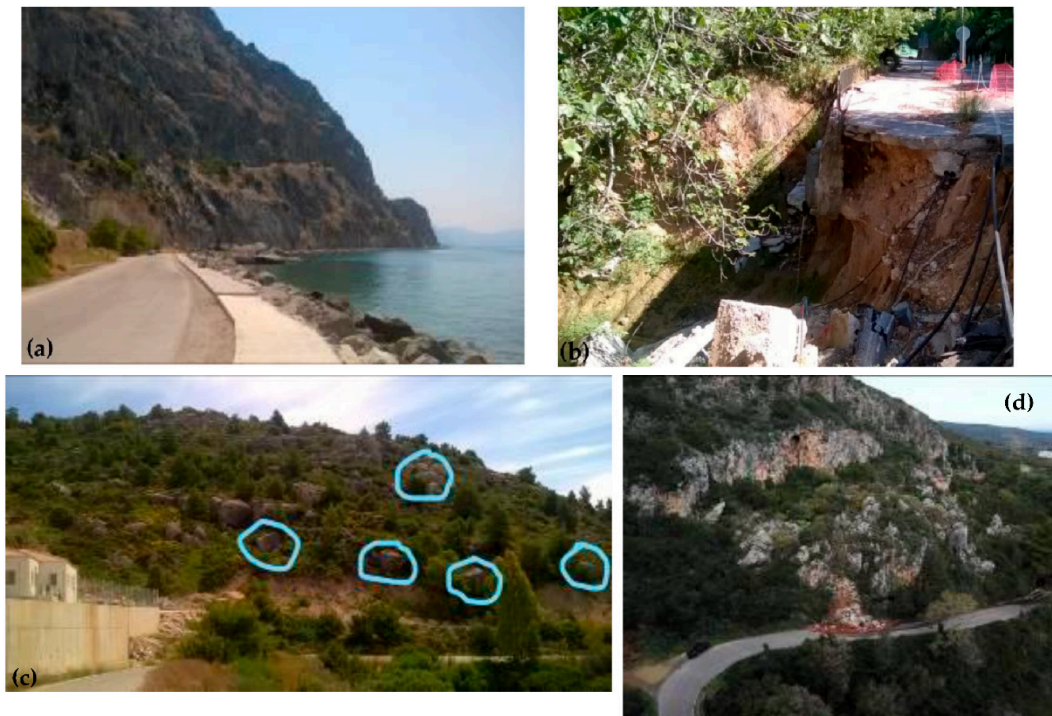
Εικόνα 6.7. (α) Παράκτιες περιοχές του Αλεποχωρίου–Ψάθα στη Βορειοδυτική Αττική που παρουσιάζουν κατολισθήσεις βράχων, (β) Το ρέμα της Χελιδονούς στον Δήμο Κηφισιάς (βόρεια της Αθήνας) προκαλεί καθίζηση στις όχθες του. (γ,δ) Κατολισθήσεις βράχων στις Σπέτσες και τα Κύθηρα. Οι κυανοί κύκλοι χρησιμοποιούνται για να τονίσουν την υψηλή πιθανότητα κατολισθήσεων βράχων.
