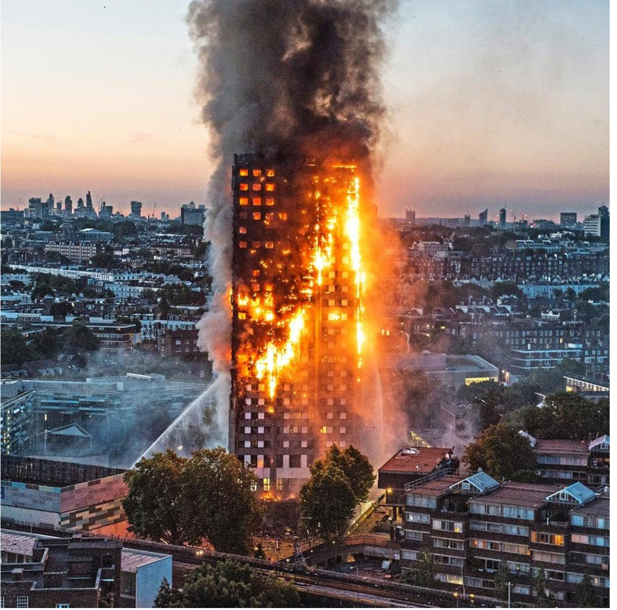
Şekil 5.46. Grenfell Tower binasında yangın
