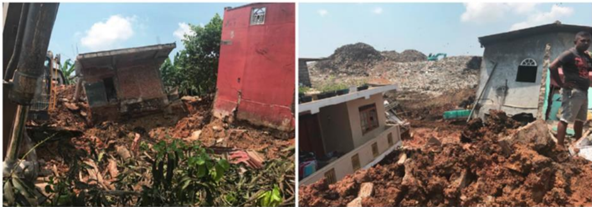
Şekil 1.4. Meethotamulla vahşi depolama sahasında şev kayması nedeniyle konut birimlerinde meydana gelen hasar (Jayaweera ve diğerleri, 2019).
